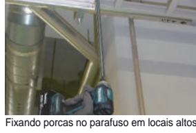
Fixando porcas no parafuso em locais altos
