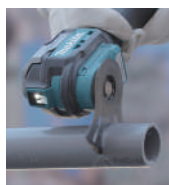
Corte de tubos de PVC.
