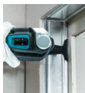
Remoção dos caixilhos das janelas.
