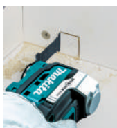
Aberturas para tomadas.
