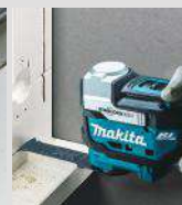
Trabalhos de abertura de portas
