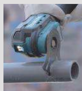
Corte de tubos de PVC
