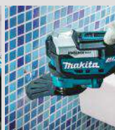
Colocação de juntas em revestimentos cerâmicos
