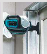
Remoção dos caixilhos das janelas
