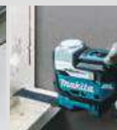
Trabalhos de abertura de portas
