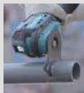
Corte de tubos de PVC
