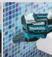
Colocação de juntas em revestimentos cerâmicos
