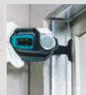
Remoção dos caixilhos das janelas
